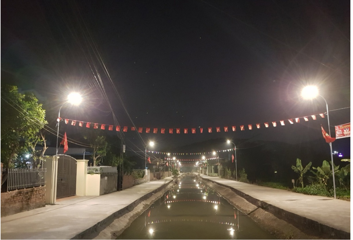
Tuyến đường ở xã An Thắng được lắp điện cao áp
