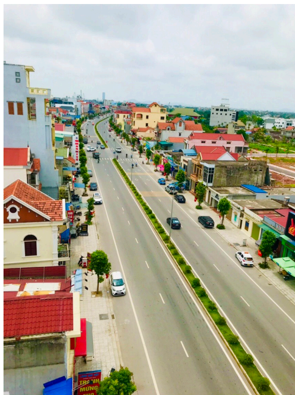
Tỉnh lộ 359, đoạn đường từ xã Thủy Sơn đến xã Tân Dương, huyện Thủy Nguyên sau khi được cải tạo, nâng cấp
